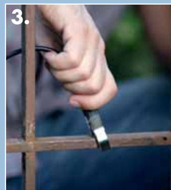
3. ... das Erdungskabel an das Metallobjekt clippen ...
